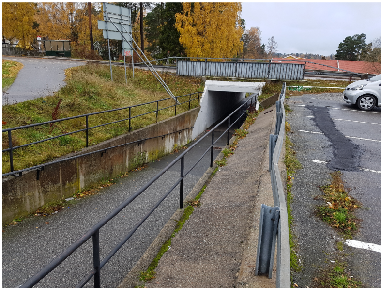
Figur 3. Ekerövägen, bro över gc-väg.
