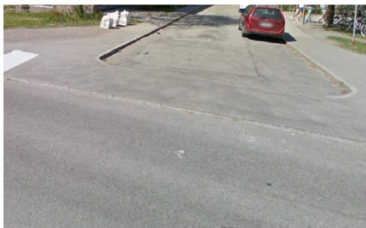
Bild som visar exempel på genomgående gångbana med avfasad kantsten i körriktningen (Ritarvägen, Bromma).
