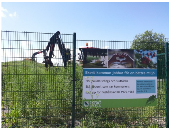
Bild vänster: Start sluttäckning Skå deponi, 2013-06-24.
