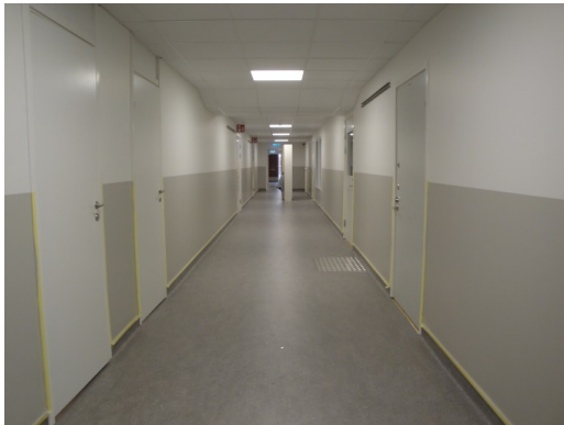
Renovering/ombyggnad i hus A på Närlundaskolan
