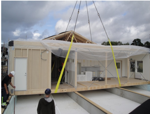
Montering av hus B på Närlundaskolan
