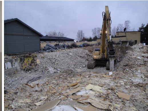
Rivning av hus L på Närlundaskolan
